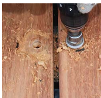
Forboring af huller til propper
